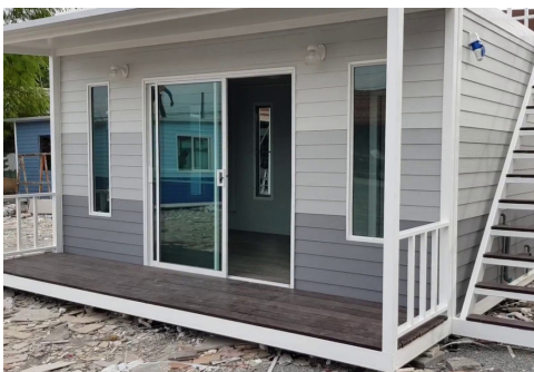
บ้านประกอบเสร็จ
